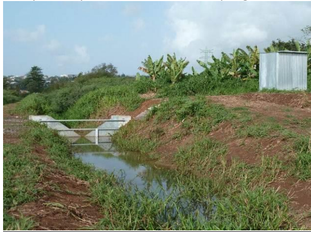
Figure 2 : Déversoir triangulaire au niveau de l'exutoire et station de prélèvement. Triangular spillway at the place of outlet and sampling station.
